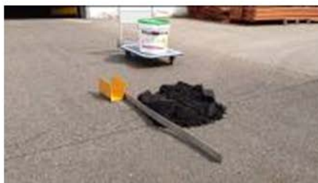
2 dépose du FILL CRACK
