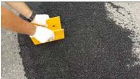
4 tassage et compactage
